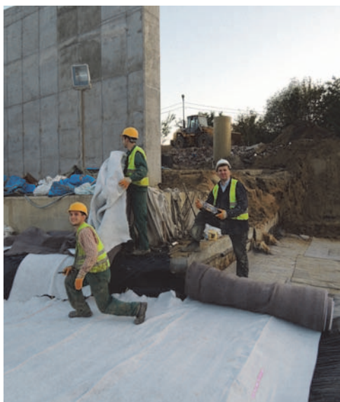
Figure 13. Mise en œuvre du géocomposite.
