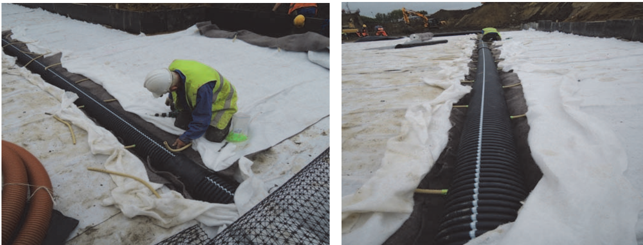
Figure 16. Raccordement du géocomposite au drain collecteur avec le système de connexion rapide.
